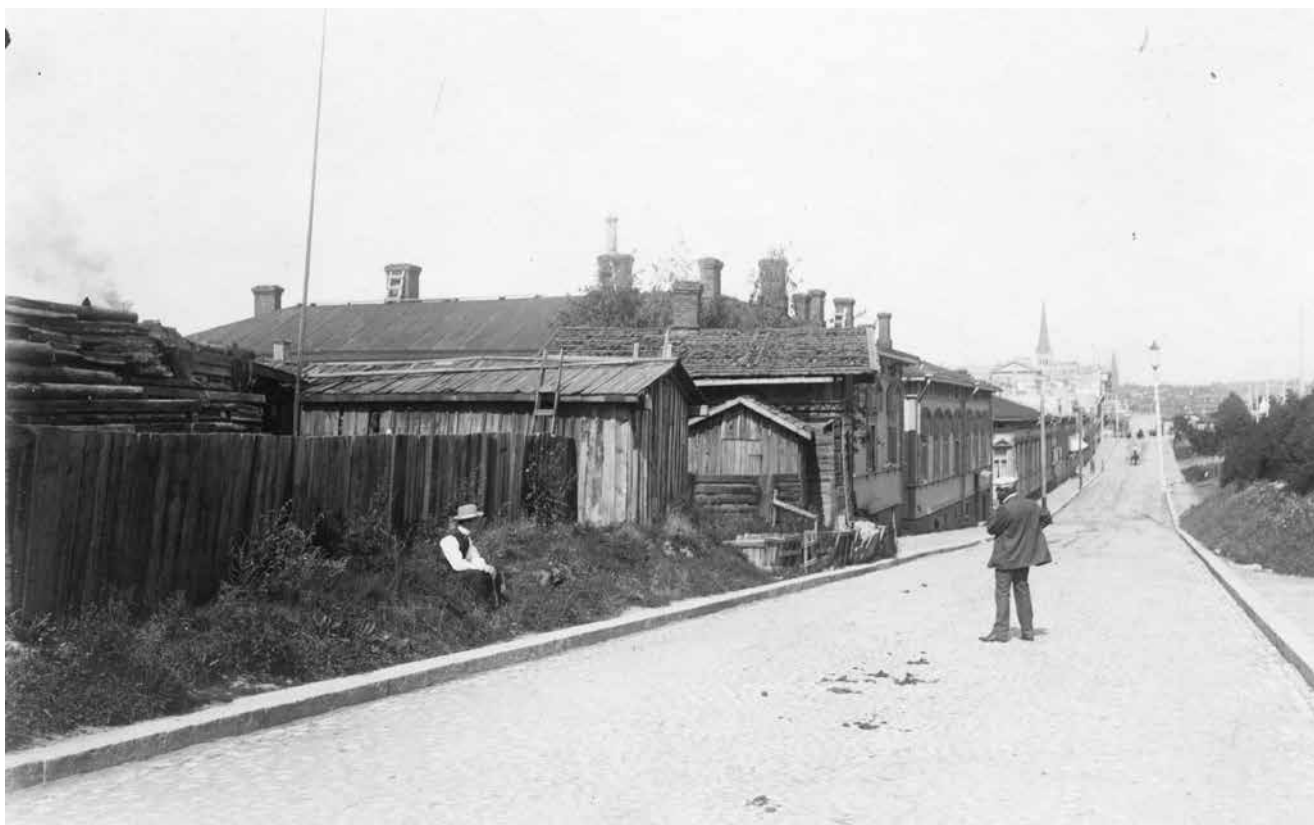
Kuva 29. Näkymä pitkin Rautatienkatua n. vuonna 1907-1910. Kuvan oikeassa reunassa näkyy ratapihan nurmipenger, jonka päällä kasvaa pensasaidanne, kauempana myös puuistutuksia. Sorinahde. R.Thüle.VKA.
