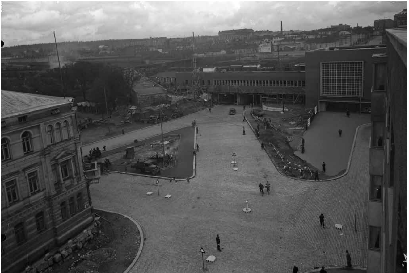
Kuva 46. 1936. Itsenäisyydenkadun, Rautatiekadun ja Hämeenkadun risteysalueen rakennustöiden viimeistely. Vasemmassa alanurkassa näkyvän Rautatiehäisten talon perustusta jouduttiin korottamaan, kun risteysaluetta madallettiin suunnitellun asema-aukion tasalle. Kolmion asfaltointi käynnissä. Taustalla näkyy osin purettu Tammelan silta ja puisto, joka on vielä työmaa-alueena. E.M. Staf. VKA.
