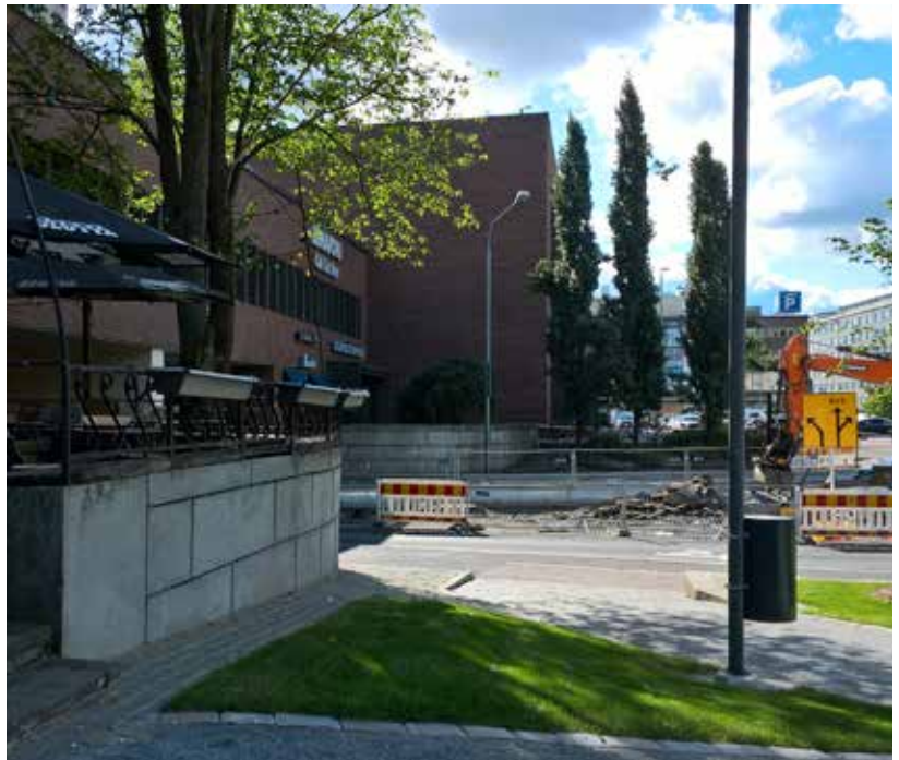
Kuva 79. Aseman edustalla on edelleen 1930-luvun alkuperäisen sommitelman mukaisesti riippasaarni. Kuvan keskellä olevat pylväshaavat ovat peräisin 1990-luvun muutoksesta. Kuva on otettu Posteljoonipuiston kunnostuksen jälkeen. Raidetyöt käynnissä. TA 2018.
